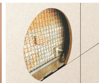
不锈钢扣槽式干挂示范 采用穿墙螺栓安装——加钢网批荡 可以弥补原砖砌墙度不足。
