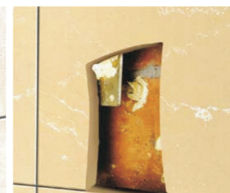
大力胶粘贴示范 采用T型构件垫贴, 适用复杂墙体 且造价低。
